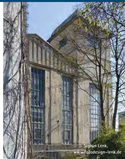
Kesselhaus, Prinz Gewerbepark
