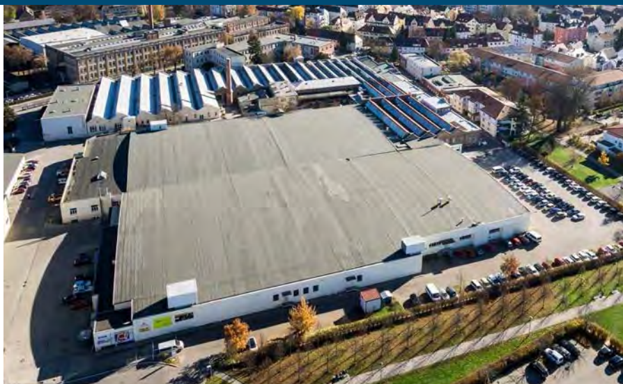
Standort Augsburg-Mühlbach: Die Hallen im Bildvordergrund werden dem Wohnbau weichen.
