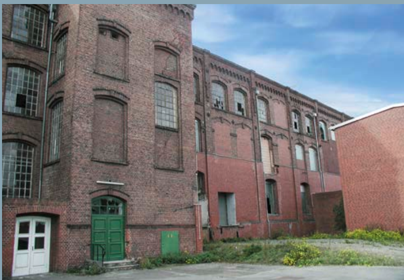
Ehemaliges Spinnereigebäude nach mehr als 10-jährigem Leerstand.
