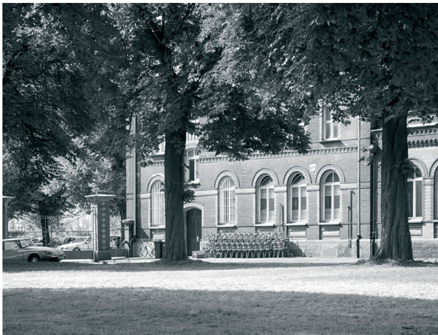
Ein zentraler Bestandteil des Umnutzungskonzeptes war es, den bestehenden Gastronomiebetrieb aufzuwerten und die Nutzung stark zu erweitern.
