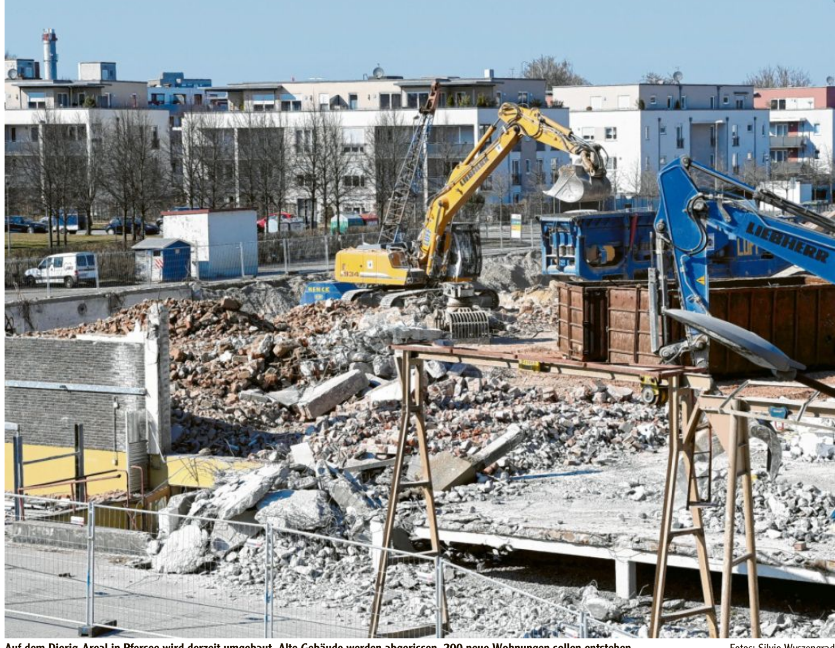
Auf dem Dierig-Areal in Pfersee wird derzeit umgebaut. Alte Gebäude werden abgerissen, 200 neue Wohnungen sollen entstehen.
