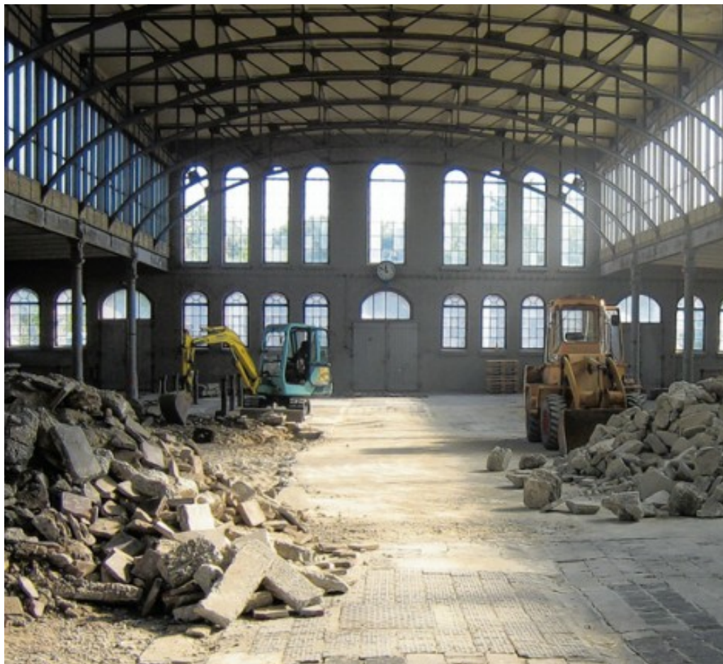
Die Tragwerke der Großvieh- und späteren Kälberhalle waren einsturzgefährdet. Nach der Sanierung enthält das Gebäude ein Restaurant mit Biergarten. Die neuen Einrichtungen wurden nach Angaben des Bezirksheimatpflegers Peter Fassl „wie Möbel in die Halle eingestellt, sodass der ursprüngliche Raumeindruck erhalten blieb.“
