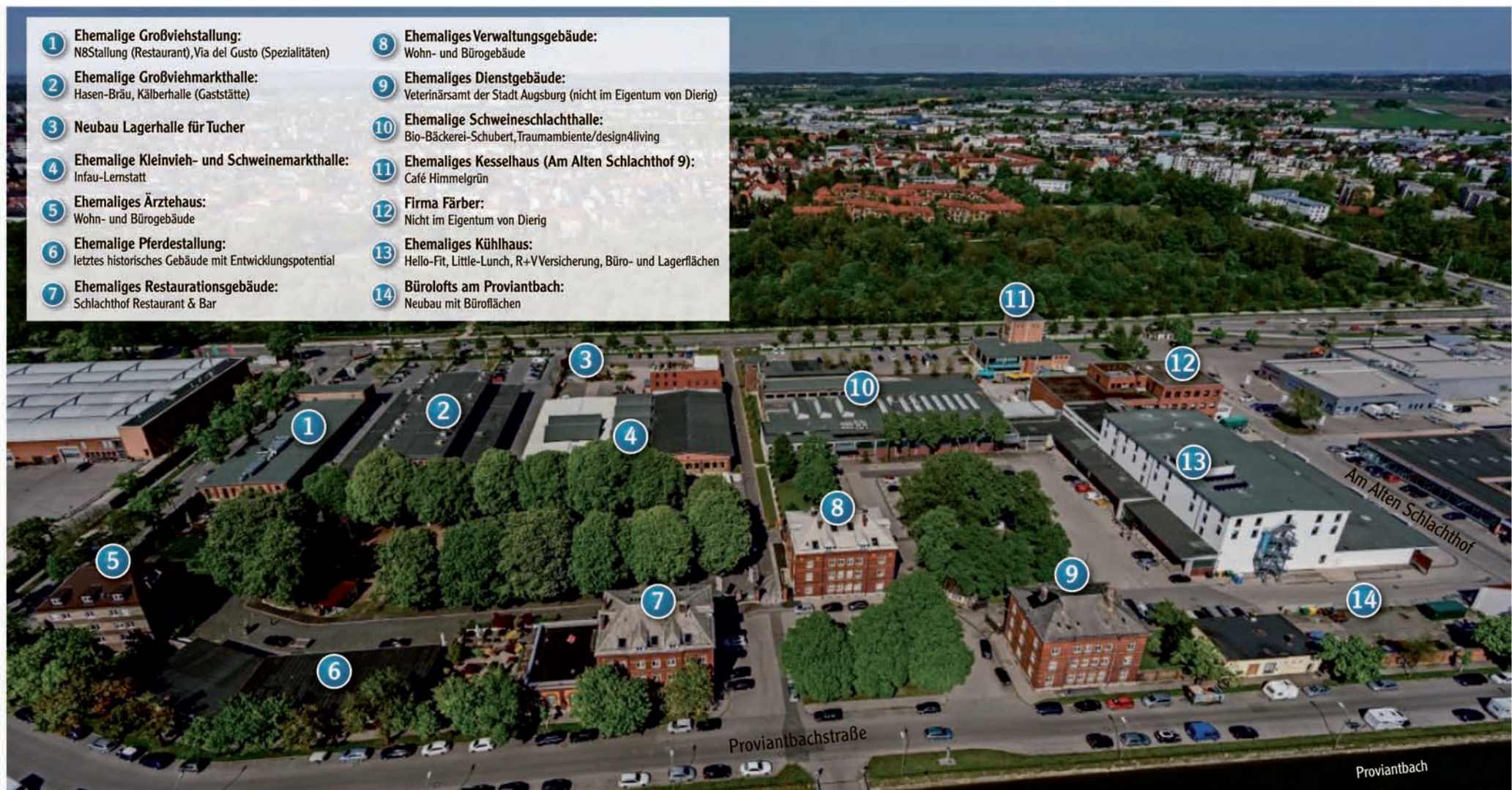
So sieht der Schlachthof heute aus. In der Legende ist zu sehen, wie die Gebäude einst genutzt waren (Großschrift) und was heute dort zu finden ist (Kleinschrift).
